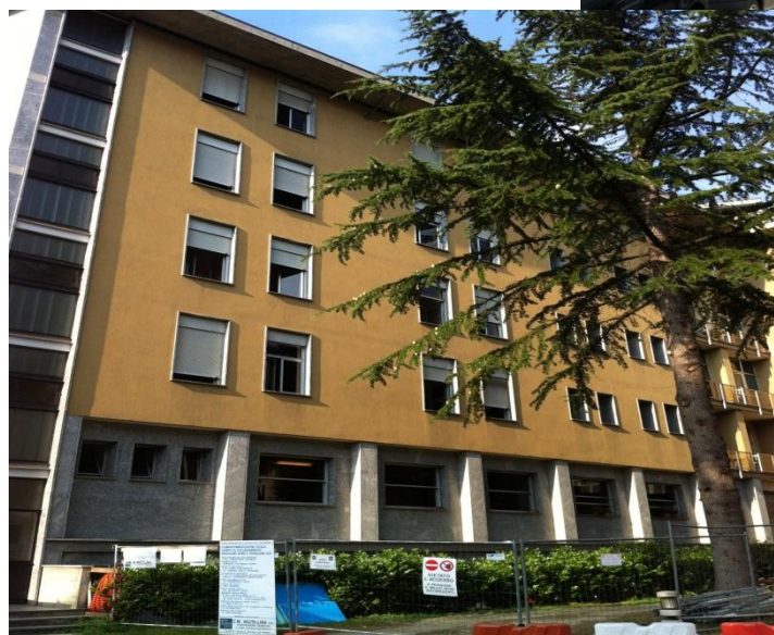
Budova interních oborů
